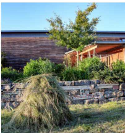
Bild 6: Trockenmauer aus Naturstein und Recycling-Material (Betonplatten, Ziegel, Grabsteine etc.).
