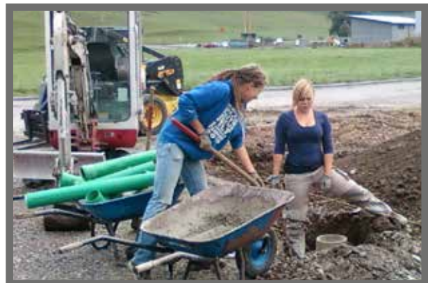
Bild 4: ... egal ob im Tiefbau,
