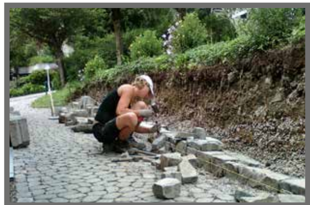
Bild 5: ... oder im Mauerwerksbau.
